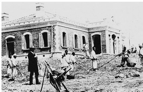
<사진 8> 배재학당 신축공사 모습
