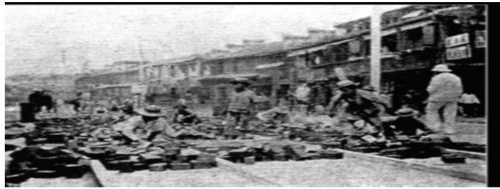
[난징루(南京路) 전차선로 공사 모습 (1908년)] 42)
