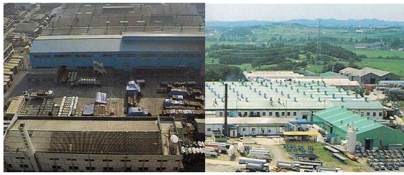
[Fig. 19] 동아자동차 전경
