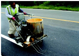
[그림 8] 노면표지 시공기 및 설치 방법 (이호원,주두환.(2013))
