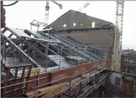
<그림 23> 붕괴된 천정부분의 복원공사 현황
