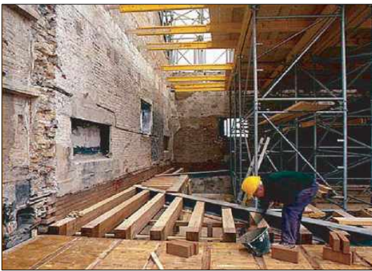
<그림 24> 관람석부분의 목재구조공사 현황
