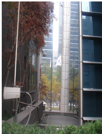
<그림 11>인접건물과의 이격거리가 불충분한 사례(사례 B)
