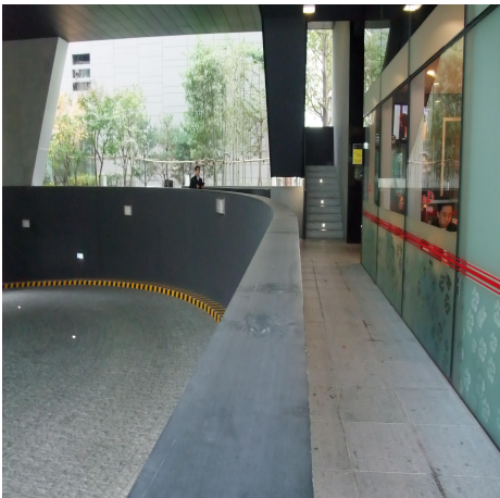
<그림 15> 건축물 1층 중앙부에 위치한 주차장 출입구(사례 F)
