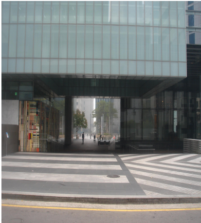
<그림 13>건축물 중심부까지 장애물이 설치되지 않은 사례(사례 C)
