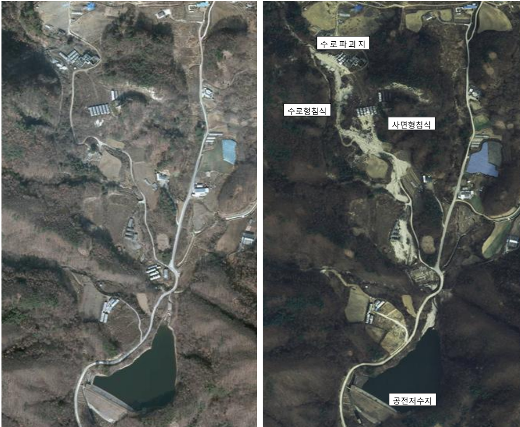
<그림 5> 제천 봉양읍 토석류 발생지 전·후 항공사진
