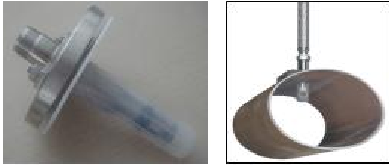
<그림 12> Fume Duct 내 스프링클러헤드 설치
