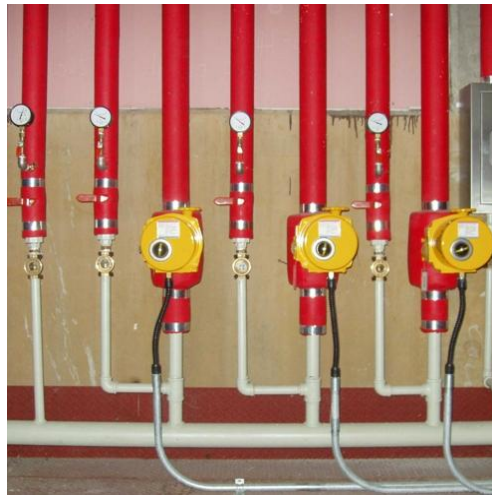
<그림 5> 배수배관에 설치된 전동기 구동밸브
