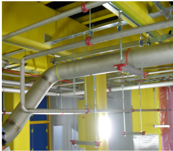
<그림 1> 클린룸 내 스테인레스 강관 설치 상태
