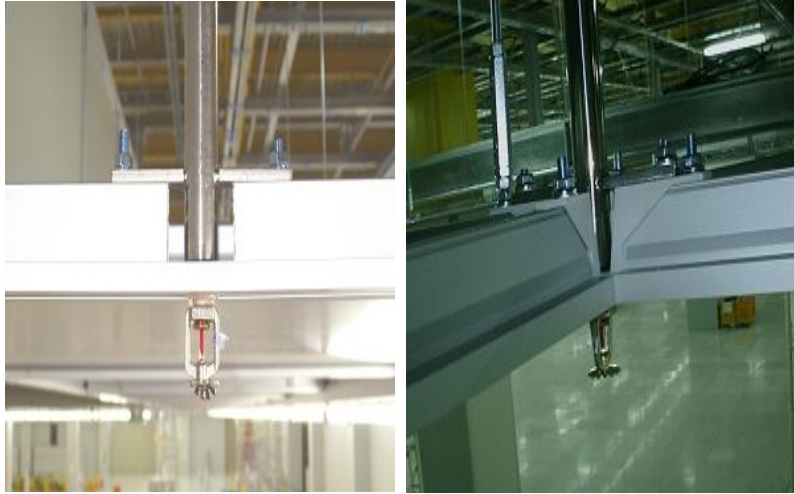
<그림 9> Mould Bar에 설치된 스프링클러헤드
