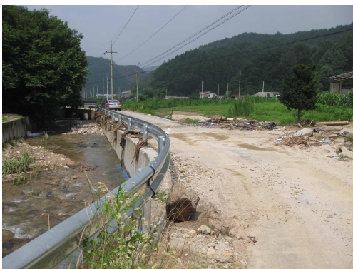
<그림 8> 파괴된 도로 전경 및 작은 배수구로 인해 월류된 토사
