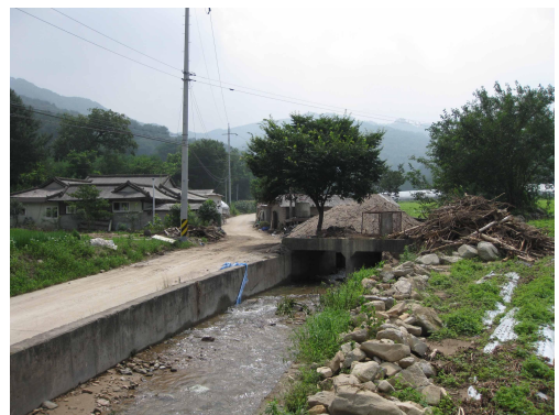
<그림 8> 파괴된 도로 전경 및 작은 배수구로 인해 월류된 토사
