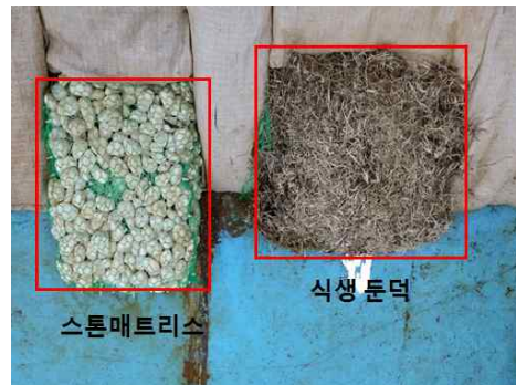
(C) 스톤매트리스와 식생둔덕의 설치 모습
