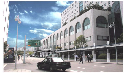
그림 26. 기타부문(캐노피) 리모델링 전·후 사진
