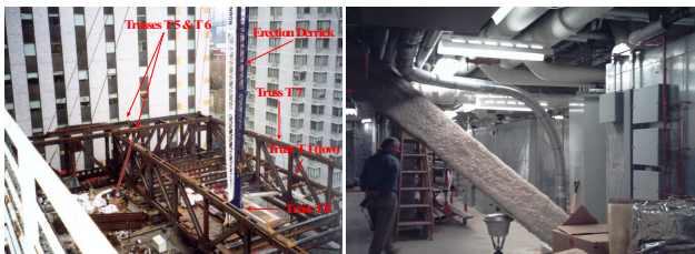
그림9. 기계실 내부와 공사사진
