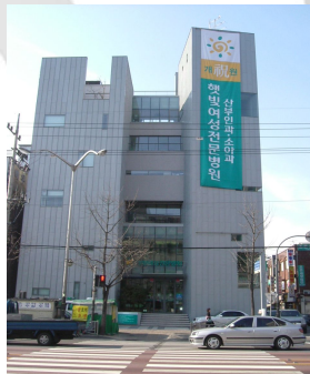
그림 7. 6차선 도로가 전면 에 있으며, 사진 우측(북측) 에 이면도로가 있다. 건물 외벽은 회색갈의 티타늄 아 연판으로 마감되었다.
