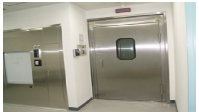
[그림 8] 양문형 고압멸균장치(좌), 에어락 도어(우)
