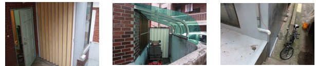
[그림 6] 기타 공사 사례
