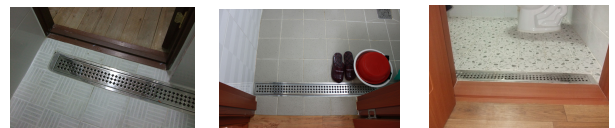
[그림 4] 트렌치 설치 방법 및 사례
