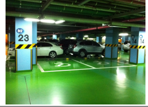
(H시설)주차구역의 안전통행로 미확보
