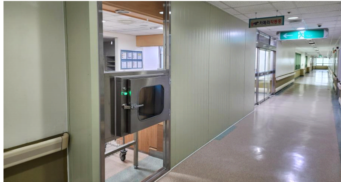
[그림 3] 긴급 전환시 설치된 간이벽체와 패스박스
