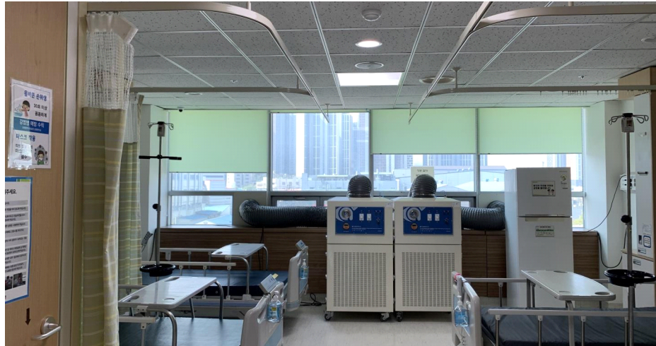
[그림 1] 이동형 음압기가 설치된 간이 전환형 긴급치료병상
