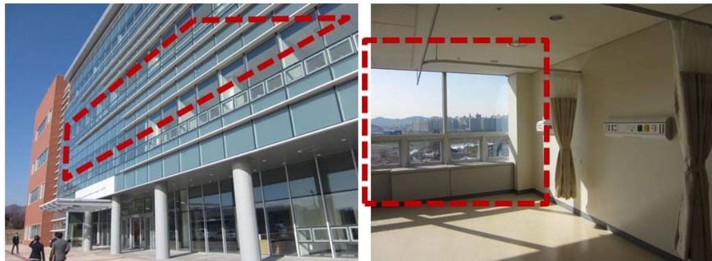
[그림 12] 칠곡경북대병원 커튼월 입면 및 병실 내부
