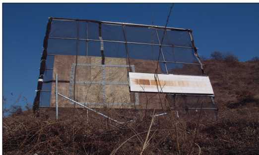
그림 8. 열상표적 야외설치 전경 Fig.8 Picture on Field Installation of ITT
