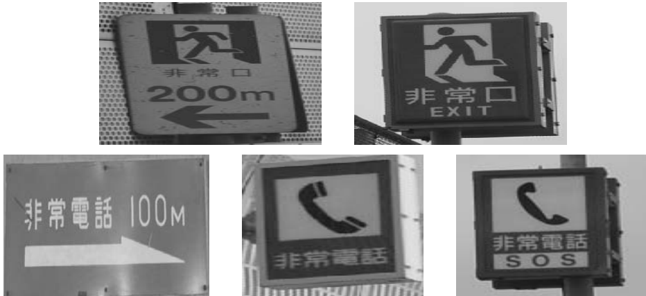
〈写真8〉「非常口」「非常電話」の例
