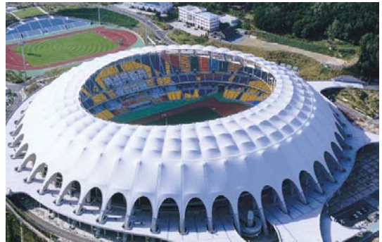
그림 2. 케이블을 사용한 부산 월드컵 경기장 Fig. 2. Busan Worldcup stadium Using cable.
