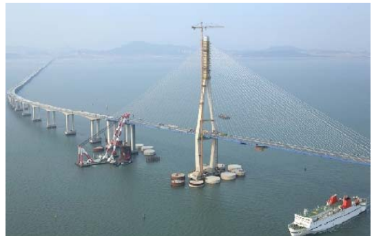
그림 3. 케이블을 사용한 인천대교 Fig. 3. Incheon bridge Using cable.
