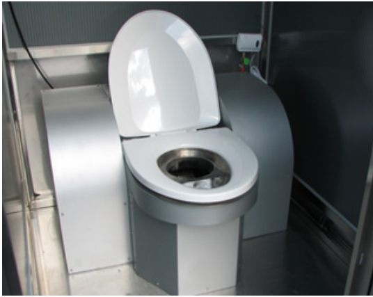
그림 5. 소각 처리 시스템 Fig. 5. Incineration system
