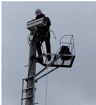
그림 2. 타임랩스 카메라의 설치 Figure 2. Installation of Timelapse Camera System
