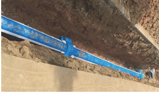
그림 4. 스마트 누수감지 시트 Figure 4. Smart Leak Detection Sheet
