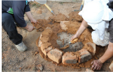
제련로 바닥면 벽돌 쌓기
