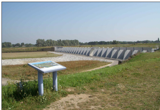
▲완공 직전의 유량조절 위어(Weir) 모습
