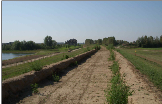
▲신규제방 건설 모습
