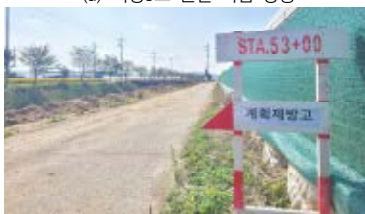
(b) 선정4교 제방고 공사 현황
