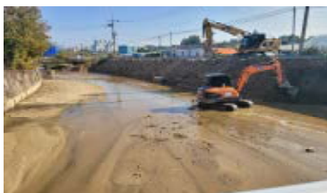
(a) 덕정3교 준설 작업 상황
