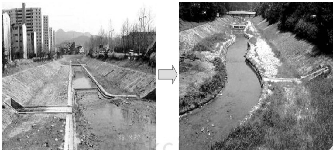
그림 1. 기존의 하천공법과 자연형 하천공법의 비교
