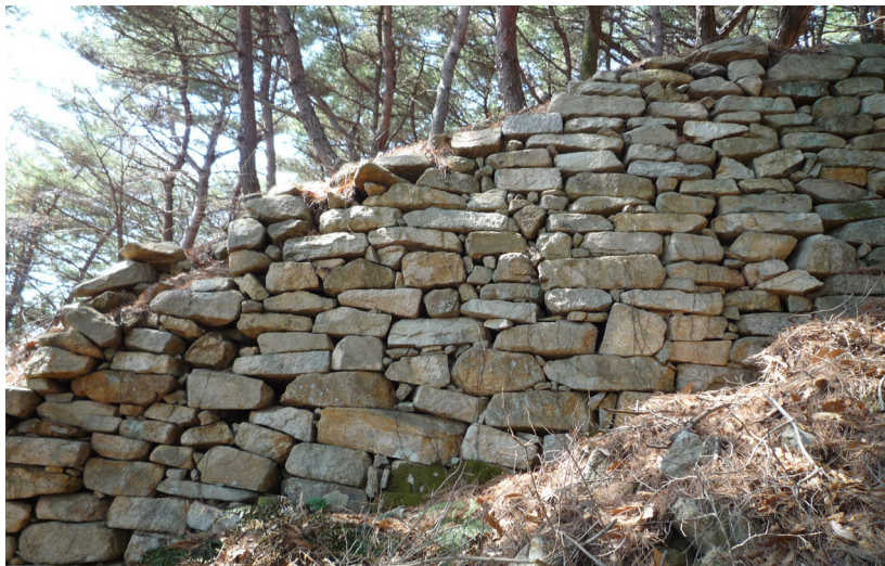
도 8. 신기리산성 동문지 북쪽 체성부 외벽 축조상태
