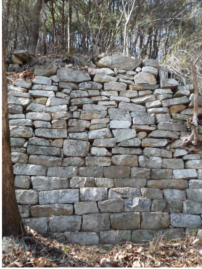
도 10. 신기리산성 동벽 체성부 외벽 축조상태 세부(아래에서 1~7단 삼국시대 내지 통일신라시대 축조, 8~18단 사이는 여말선초, 그 위로는 조선시대 후기로 추정)
