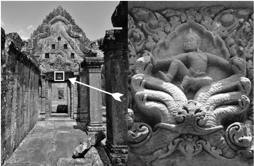
[9] 상인방의 사각형 속에 끄리시나가 나가 깔리야를 제압하는 장면이 오른쪽에 확대되어있다. 출입문의 박공벽에 직사각형의 홈이 보이는데, 그것은 지붕을 만들기 위한 버팀목의 자리이다. 이것으로 당시에 고뿌라의 지붕은 사람이 아닌 목재로 제작되었다는 사실이 드러난다.
